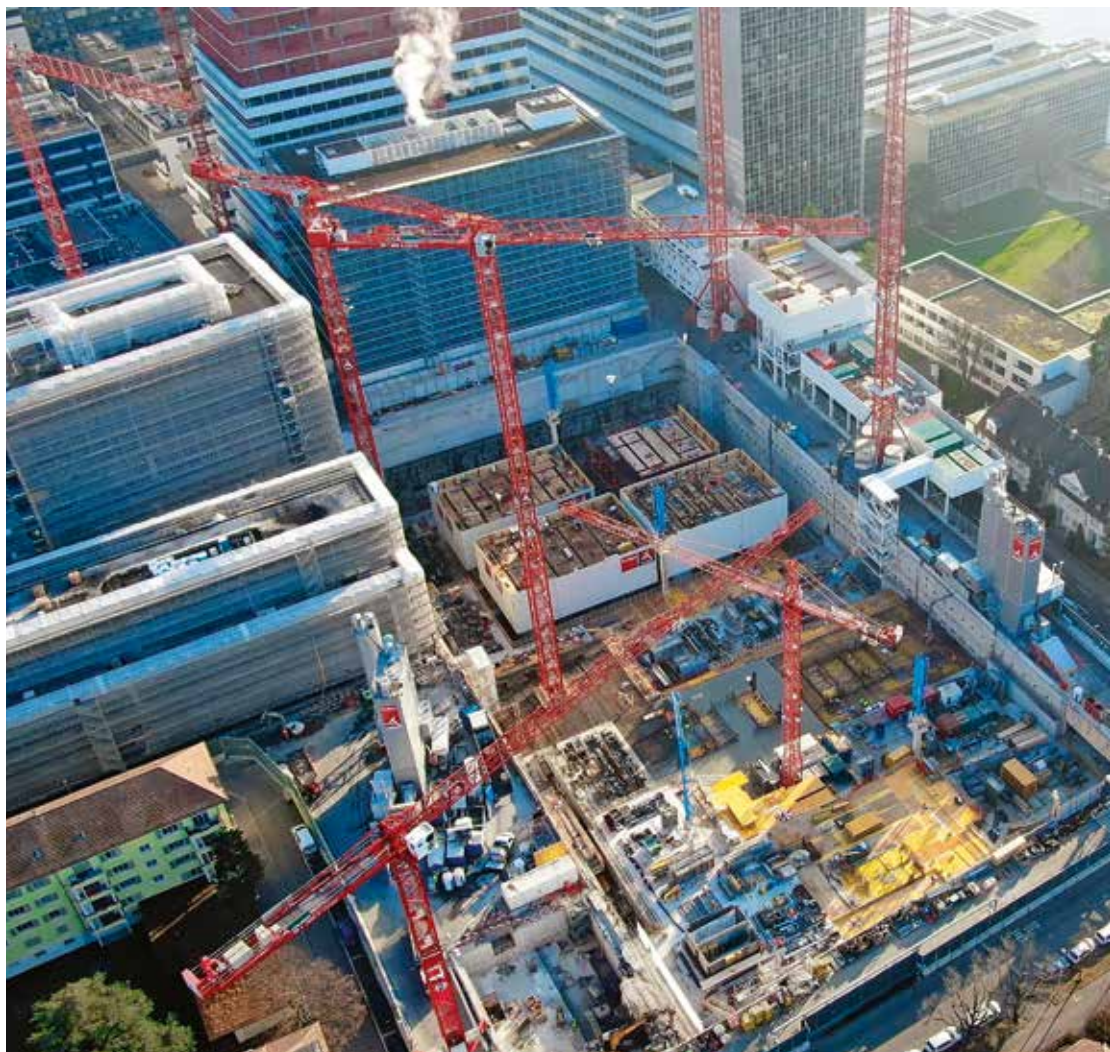
Neue Chancen: Roche-Baustelle in Basel.
